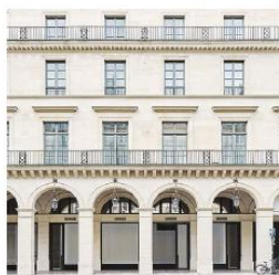
Larry Gagosian ouvre une troisième galerie à Paris, au 9, rue de Castiglione (1 er ).
